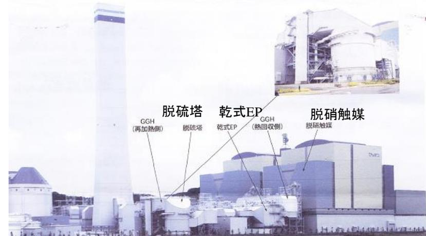
図51-20 石炭焚きボイラの排ガス設備例 (橘湾火力発電所2号機)
