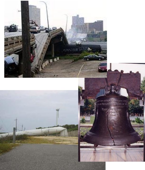
機械の破壊事故（上から－ミネアポリス高速道路崩落事故/腐食、自由の鐘/オーバロード、狩俣風力発電倒壊/強風
