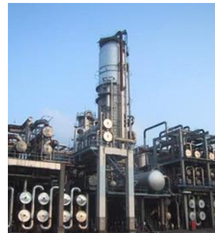
図42-28 常圧蒸留装置 (出光)
