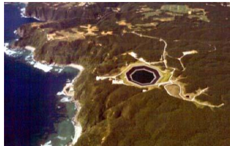
図31-13 やんばる海水揚水発電所(上池)
