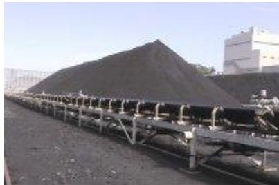
図31-34 貯炭場(敦賀発電所)
