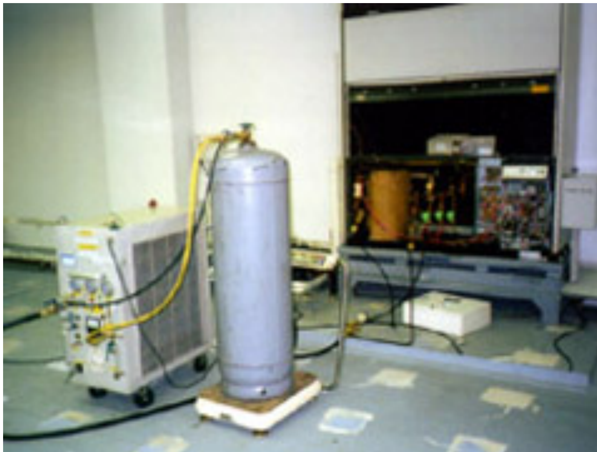
フロン回収作業
