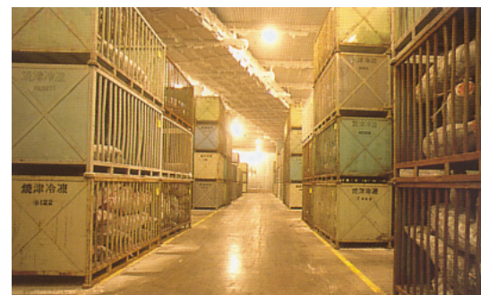
図25-9a -60^{\circ}\text{C} の冷蔵室 (前川製作所製)
