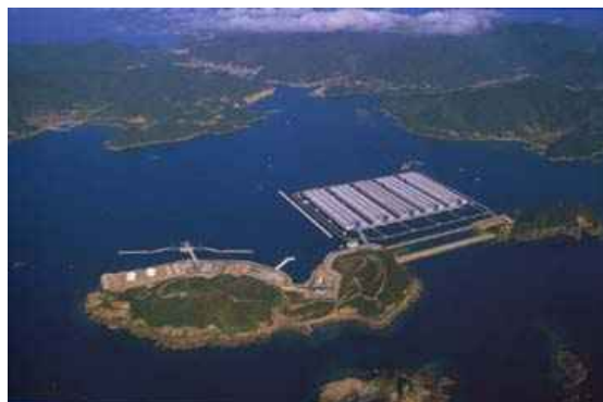
図20-14a 上五島洋上石油備蓄基地
