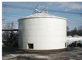
図7-21 冷気で氷を作るアイスシェルター(北海道帯広市)
