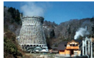
図7-12 松川地熱発電所発電出力23,500kw
